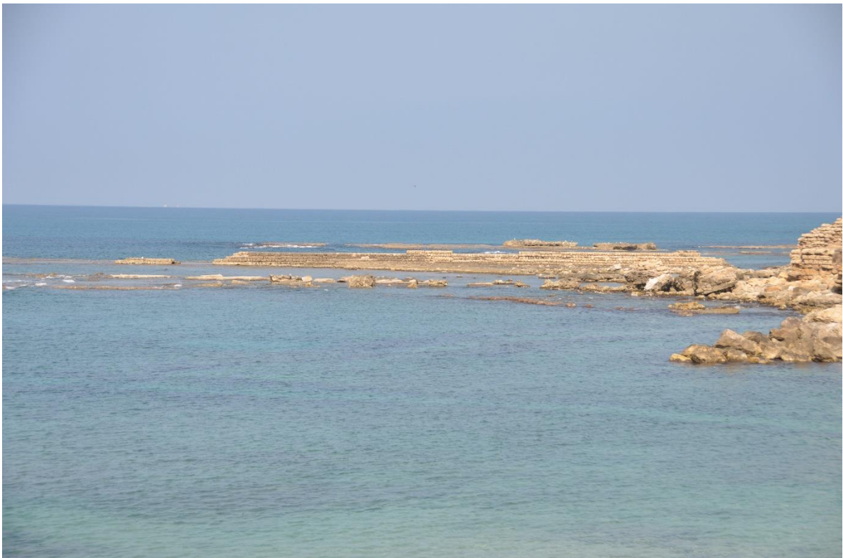
Caesarea: de pier van de haven, het oudst-bekende voorbeeld van onder water uithardend beton.
