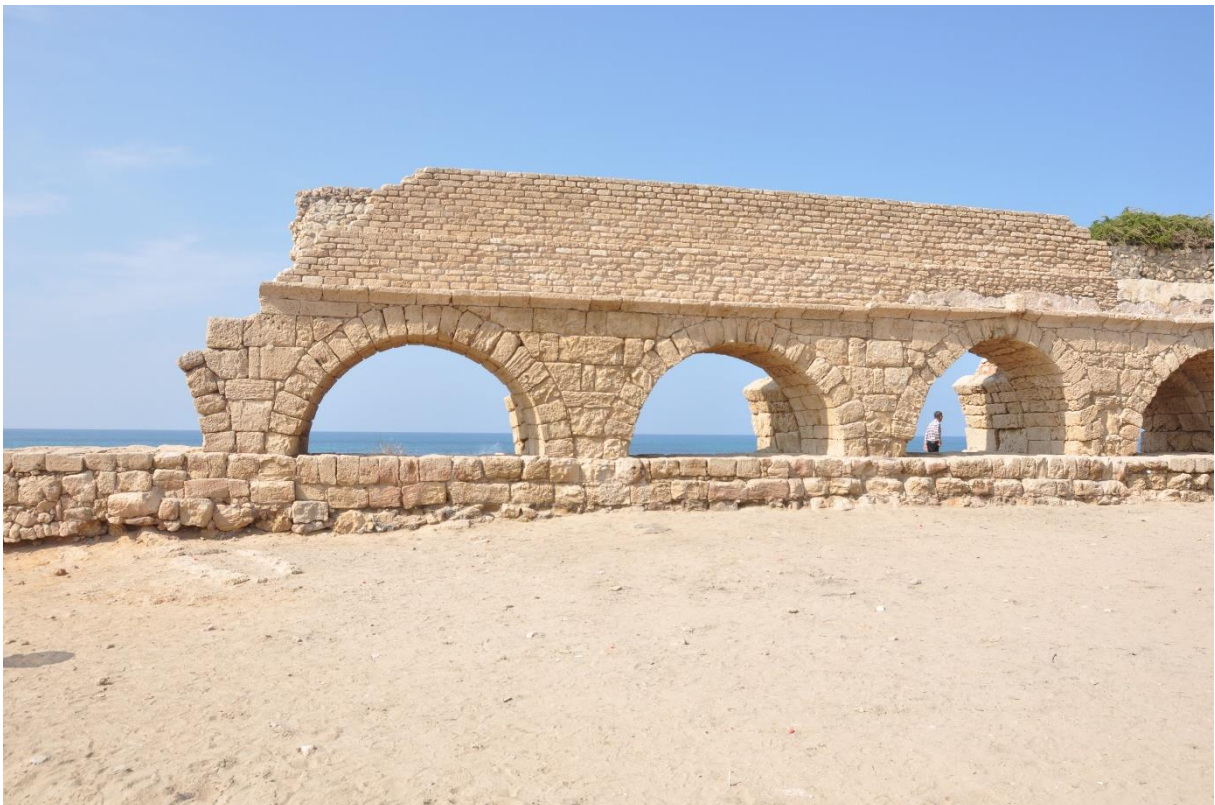
De bouwprojecten van koning Herodes in zijn hoofdstad Caesarea: een aquaduct.
